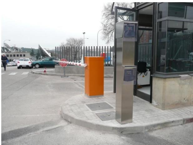
Para el caso de los accesos que se producen cuando los empleados entran a los diferentes centros con vehículos, se han instalado barreras automáticas y báculos que alojan los terminales B-Net 93 20 de control de accesos y tiempos. El acceso se produce con la misma lógica funcional que en los dos casos anteriormente descritos.
