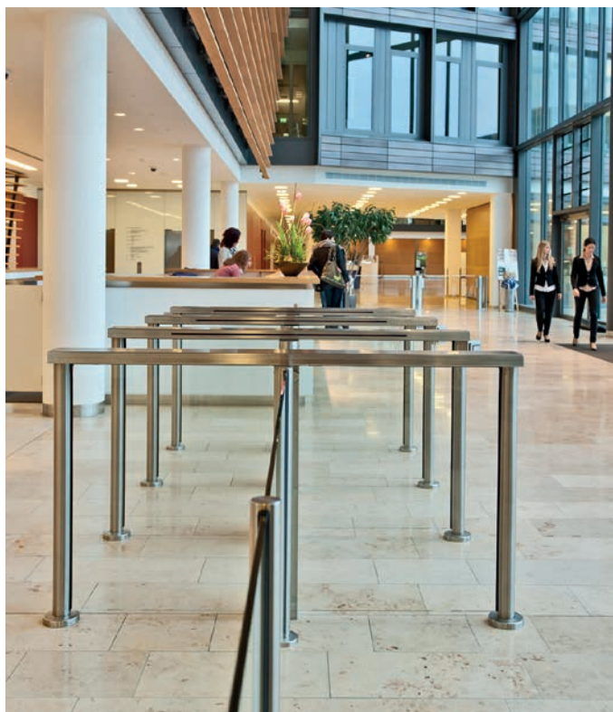
Barreras de sensores con instalaciones de ampliación
